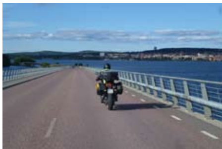
Lång vägbro med utsikt över Östersund
