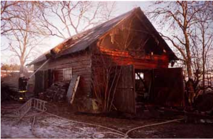
En pyroman hittade en bensindunk i vår vedbod som plötsligt började brinna. Men halva byggnaden gick att rädda och renoverades senare.
