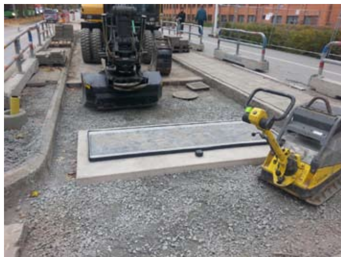
Installationen av "dynamiska farthindren" Acti-Bump pågick i september.
